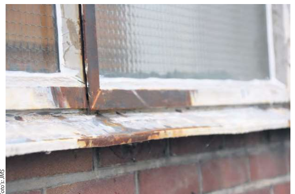
De oorspronkelijke metalen kozijnen worden zo roestvrij mogelijk geslepen. Daarna geprimeerd met een roestwerende primer en dan afgelakt met Allure
