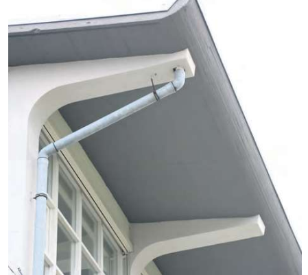
De kenmerkende overkapping van het fabriekspand aan de zuidzijde is al zo ver af als de zelfrijder kon komen, de rest wordt vanaf het dak geschilderd
